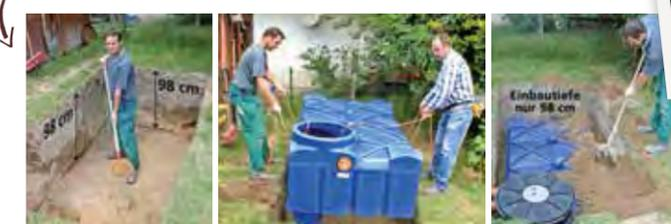
*Grube ausheben ... .. Tank positionieren ... .. Grube füllen, fertig!*
