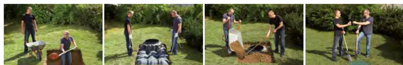
*Grube ausheben ... .. Tank einsetzen ... .. Grube auffüllen ... .. fertig!*
